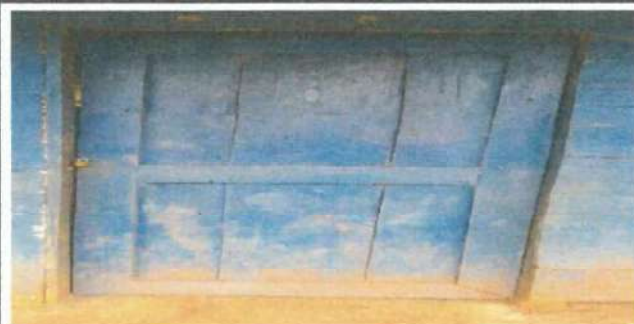
Foto 5: Se identifica que la puerta del centro educativo requiere remozamiento, ya que se encuentra en mal estado debido al desgaste y deterioro natural de la madera.
