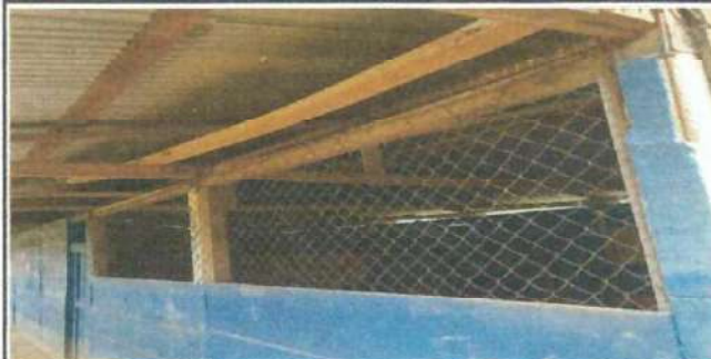
Foto 6: Se observa que las ventanas del centro educativo se encuentran en mal estado debido al deterioro de la madera, lo que afecta su funcionalidad y seguridad.
